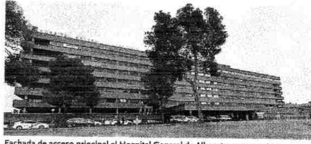
Fachada de acceso principal al Hospital General de Albacete. / ARTURO PÉREZ
